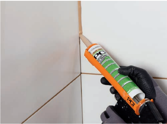
PCI Silcofug® E er modstandsdygtig over foralmindelige rengøringsmidler og desinfektionsmidler. Fugen kan nemt rengøres.
