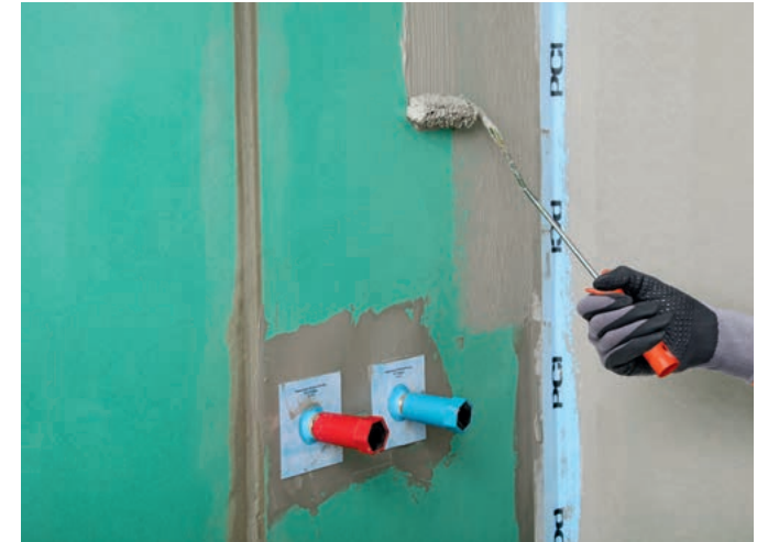
PCI Lastogum® påføres ufortyndet på underlaget ved rulning, strygning eller spartling.
