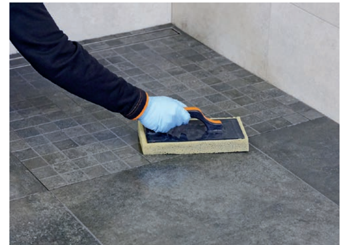
Specielt til fugning af overflader, hvor udseendet er meget vigtigt, som fx fliser, mosaik osv.
