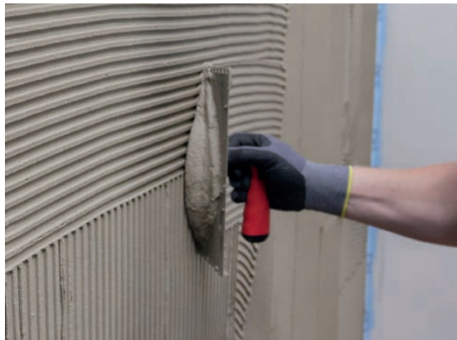
Til belægning af cementafretningslag allerede fra ≤ 4% CM resterende fugt.
