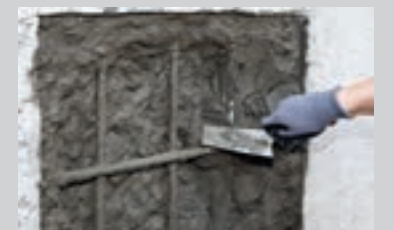
Hæftesvumme påføres med det første lag reparationsmørtel
