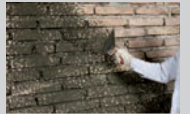
Påføring af en udkastmørtel tilsat PCI Emulsion
