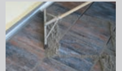
Fordeling af den drænende fugemørtel til brostensbelægninger PCI Pavifix® 1K Extra på den forvandede naturstensflade
