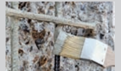
Den aktive armeringsbeskyttelse PCI Nanocret® AP påføres heldækkende i minimum to lag
