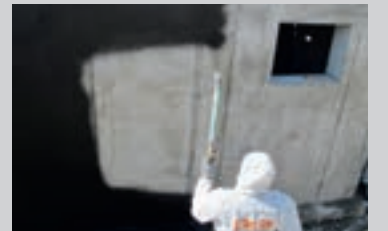
Grundning af et sugende underlag med PCI Pecimor® F
