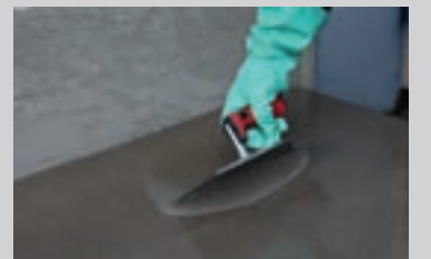
Den porefri skrabespartling bestående af PCI PUR-Grund blandet med kvartssand 0,06 til 0,30 giver sikker vedhæftning og boblefri hærdning af den efterfølgende belægning
