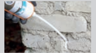
Injektion af en vandafvisende horizontalspærre med PCI Barra® Creme
