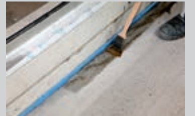
Anvendelse af en primer med PCI PUR base letter påføringen af en skrabespartling
