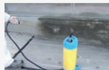
Manuel påføring af en PCI Silconal®-hydrofobering som ikke-filmdannende vand- og smudsafvisende foranstaltning
