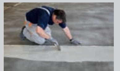
Manuel forarbejdning imod en ekspansionsfuge
