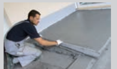
Med additiver som PCI Estrifix® og PCI Tætningsmørtel forbedres forarbejdningen i cementbaserede afretningslag
