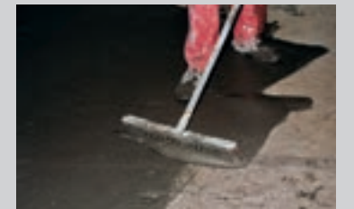
Påføring af en mørtelhæftebro med PCI Pecihaft®
