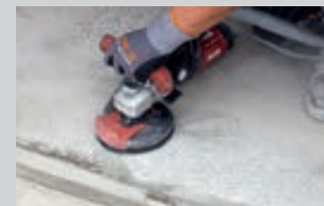
Afrensning af overfladen med diamantsliber
