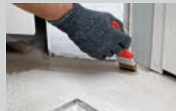
Manuel påføring af den matte topcoat PCI Finopur®
