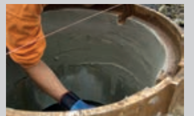
Foring af en brøndring og sætning med PCI Polyfix® plus L
