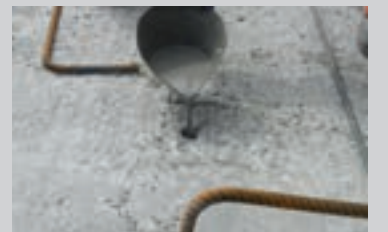
Fyldning af borehuller med PCI Polyfix® 5 min.
