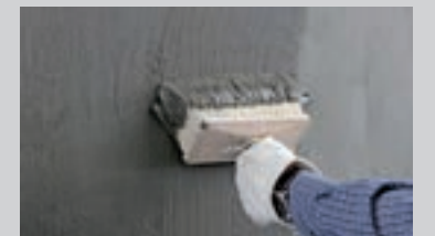
Påføring af den mineralske, sulfatbestandige tætning PCI Barraseal®
