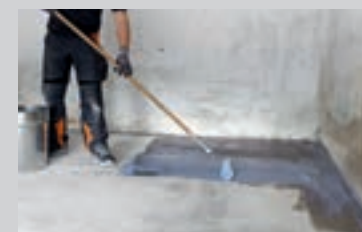
Priming to gange med PCI Gisogrund® 404 (langs- og tværgående bevægelse giver en sikker vedhæftning af gulvudjævningsmassen til underlaget)
