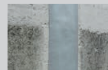
Tætning af to færdige elementer med PCI Pecitape® 3000
