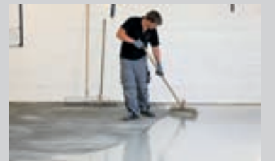
Fordeling med gummiskrabber og pigrulle
