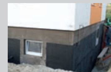
Overgang på en sort tætning med PCI Barraseal® Turbo over terrænniveau
