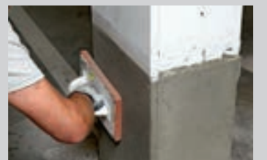
Lukning af lunger med spartelmassen PCI Nanocret® FC
