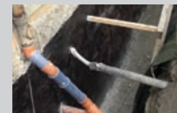
PCI Barraseal® Turbo klæber selv på gamle bitumentætninger
