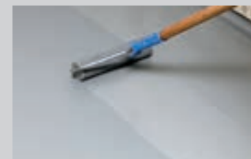
Efter maling to gange med PCI Supracolor er den visuelle renovering afsluttet
