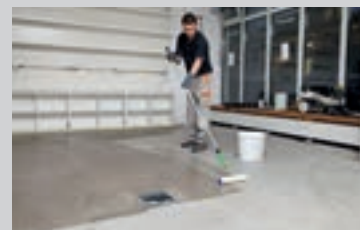
Efter ca. 1 døgn kan de cementbaserede gulvudjævningsmasser forsegles med en topcoat, fx PCI Zemtec® Top
