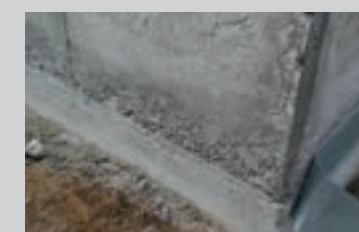
Tætning af en konstruktionsfuge med PCI Pecitape® 3000
