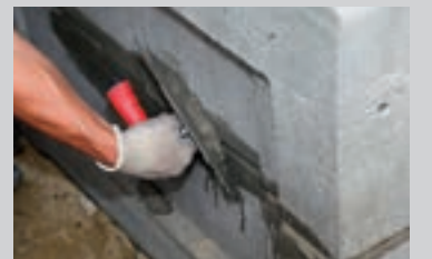
Reparation af fuger og udbedring af hjørner og kanter med PCI Nanocret® R2
