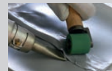
Svejsning af tætningsbånd og klæbning af skrå samlinger udføres med en varmluftpistol. Bevægelse i svejsningen skal være sikret
