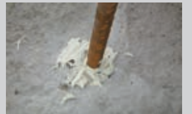
Fyldning af borehuller med PCI Polyfix® 5 min.
