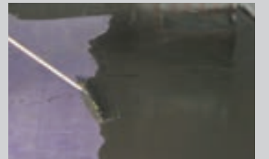
Efter 3 timer kan en gulvudjævningsmasse påføres, fx med PCI Zemtec® 1K
