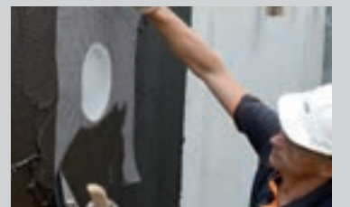
Ilægning af PCI Armeringsvæv omkring en rørgennemføring
