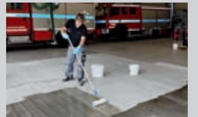
Grunding af den forberedte flade med epoxyharpiks som fx PCI Epoxigrund 390
