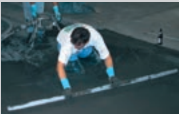
Svømmende afretningslag skal påføres i homogene lagtykkelser
