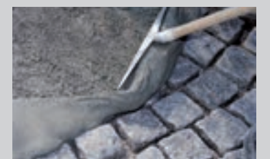
Fordeling af den cementbaserede fugemørtel til brostenslægninger PCI Pavifix® CEM på en forvandet brostensflade
