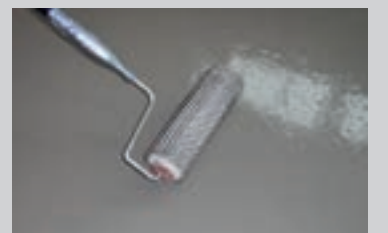
Materialet fordeles jævnt og udluftes med en pigrulle
