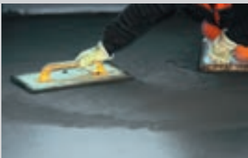
Der skal evt. laves en opretning under isoleringen
