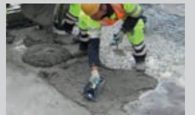
Standfast gulvudjævning af en betonafskalning med PCI Repafast® Tixo
