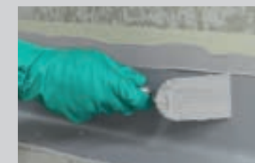
Tætningsbåndet PCI Pecitape® 3000 trykkes omhyggeligt på plads og stryges glat med en murske
