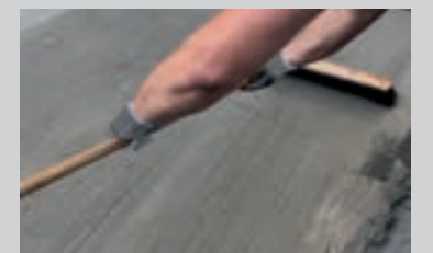
Udførelse af afkostning på PCI Peciment® 50
