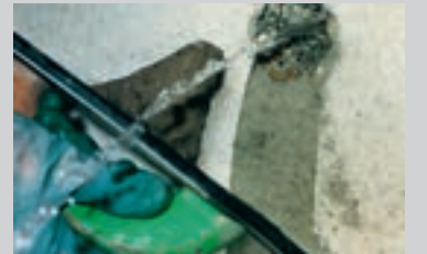
PCI Polyfix® 30 sek. som lyn-cementmørtel til hurtig tætning af vandindtrængninger
