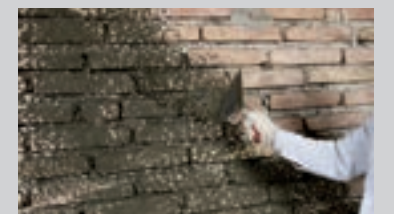
I saneringspudssystemet påføres mørteludkast PCI Saniment® HA med en dækningsgrad på ca. 50 procent
