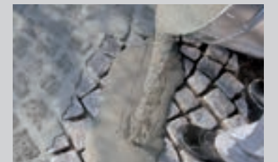
Fordeling af den drænende fugemørtel til brostensbelægninger PCI Pavifix® 1K Extra på den forvandede naturstensflade
