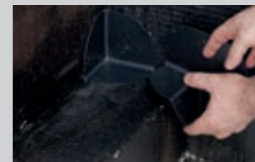
Kritiske hjørner sikres sikkert med PVC-formdele PCI BT 45 og PCI BT 46
