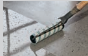
Påføring af en uv-stabil topforsegling, fx PCI Finopur®
