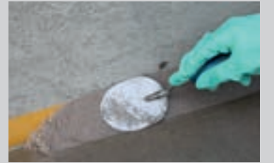
Fremstilling af en hulkel af PCI Bauharz blandet med kvartssand
