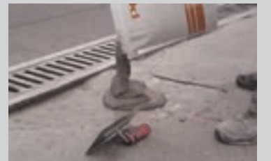
Selvudflydende udjævning af en gulvflade af beton med PCI Repafast® Fluid
