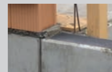
PCI Barraseal® Turbo som tætning under vægge
