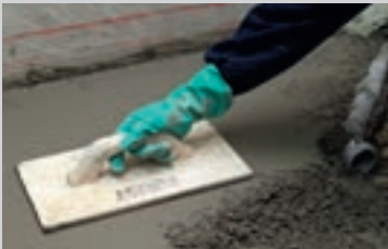
Hurtigmørtlen PCI Novoment® skal påføres på hæftebroen vådt i vådt
