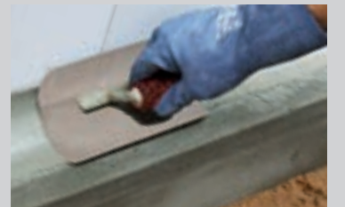
Fremstilling af en hulkel ved overgangen med PCI Polyfix® plus L
