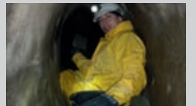
Påføring af den sulfatbestandige tætningssvumme PCI Barraseal® i en spildevandskanal
