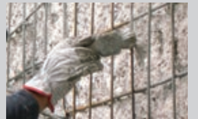
Forbehandling af armeringsjernene med den aktivt udstyrede armeringsbeskyttelse PCI Nanocret® AP
