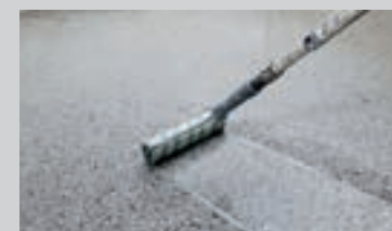
Valgfrit idrysses PCI Farbchips, og den dekorativt designede overflade forsegles lysægte og silkemat med PCI Finopur®
