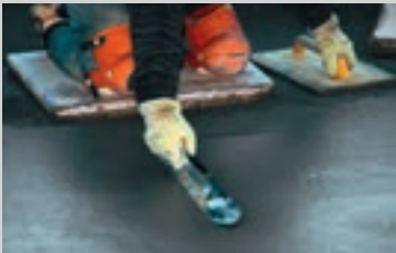
Afretningslag glittes med et glittebræt eller en glittemaskine
