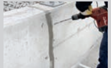
Der bores huller skråt ind mod revnens forløb fra skiftevis højre og venstre. Borehullet skal ramme revnen ca. i midten.
