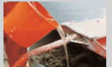
Påføring af en udkastmørtel tilsat PCI Emulsion
