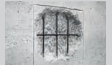
Armeringsjernene afrenses for rust og gamle belægninger
