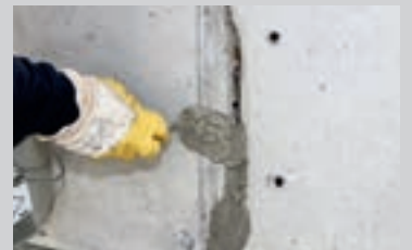
Revner og sprækker lukkes omhyggeligt med mørtel (udvides evt. forinden)
