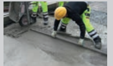
Stabil udjævning af en gulvflade af beton med PCI Repafast® Tixo
