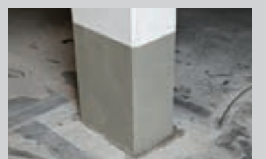
Søjle bearbejdet med spartelmassen PCI Nanocret® FC
