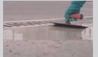
Støbning imod en rende med epoxy-flydemørtlen PCI Repaflow® EP Plus
