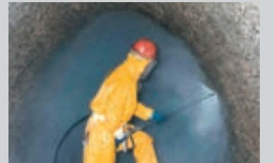
Forberedelse af en beskadiget betonoverflade i en kloak
