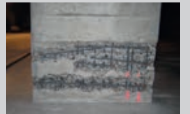
Frilægning af kloridskadede beton i en garage
