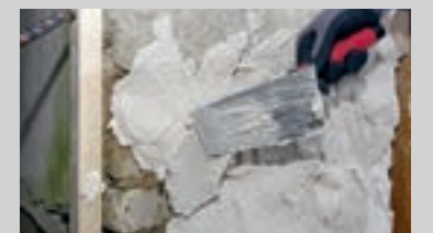
Påføring af PCI Saniment® 2 in 1 som saneringspuds og finpuds i ét produkt
