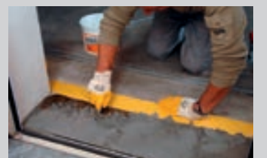
Udjævning af en tærskel eller et trappetrin med den standfaste epoxy-mørtel PCI Aposan®
