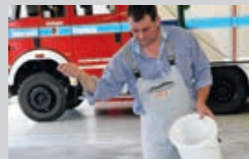
Idrysning af farvechips i den friske belægning
