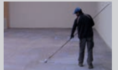
Før lægning af den flydende gulvudjævningsmasse påføres PCI Gisogrund® 404 som hæftegrunder
