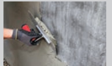
Påføring af fiberforstærket spartelmasse PCI Nanocret® FC
