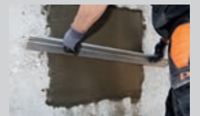
Reparationsfladerne afrettes til plan overflade og færdigbearbejdes
