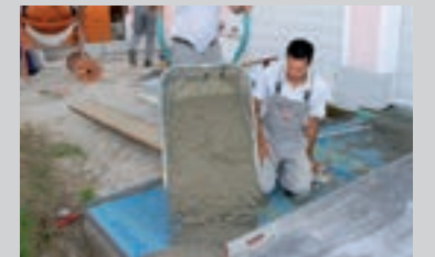
Lægning af drænmørtel PCI Pavifix® DM på en underliggende drænmåtte
