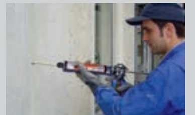
Fyldning og fiksering af forankringer med methacrylat PCI Barrafix® 920
