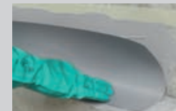
Epoxy-klæberen PCI Barrafix® EP påføres jævnt, og tætningsbåndet lægges i
