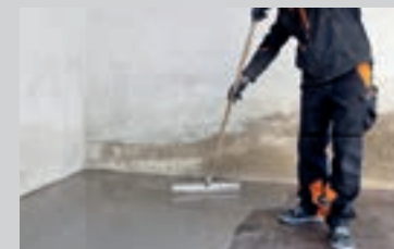
Fordelet blandet PCI Zemtec® 1K jævnt, og udluft derefter materialet med en pigrulle
