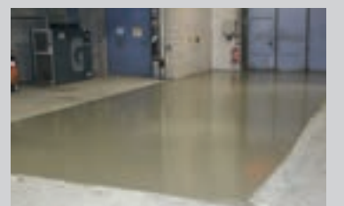
Udjævning af et betongulv med let udflydende flydegulv PCI Zemtec® 180
