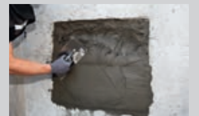
Reparationsmørtlen, fx PCI Nanocret® R4 PCC, påføres uden hulrum manuelt eller maskinelt
