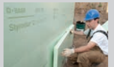
PCI Pecimor® DK påføres på isoleringspladen på hele fladen, og den klæbes på. Over grundvandsniveauet er punktuelt klæbning tilladt. De enkelte pladers stød spartles med PCI Pecimor® DK.
