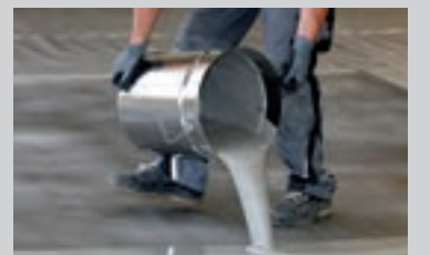
Påføring af den flydende belægning
