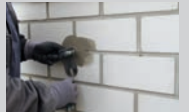
Forankring af indbygningsdele ved hjælp af cementbaseret mørtel som fx PCI Repafix®
