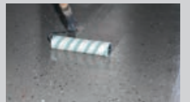
De idrysede farvechips skal forsegles transparent med PCI Pursol®. Ved belægninger uden farvechips kan det andet lag påføres som farvet PCI Pursol® 1K.
