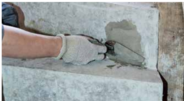
Afskalninger og brud tættes hurtigt med PCI Polyfix®, som tåler vejr og vind.
