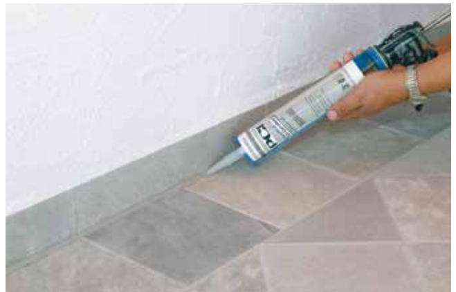
Ved at bruge PCI Carraferm® undgås misfarvning i randzonerne mellem natursten og andre flader.
