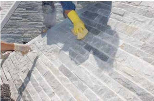
Ved fugning af naturstensfliser bruges specialfugemørtlen PCI Carrafug®.
