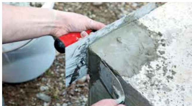
PCI Polyfix® til udbedring af ødelagte hjørner og kanter.
