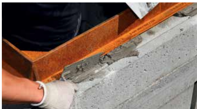
Brøndkarm støbes fast med PCI Repafast® Tixo.
