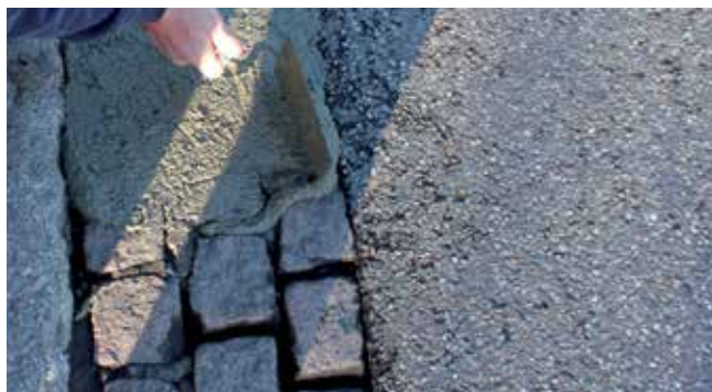
På grund af de selvudflydende egenskaber er PCI Repafast® Fluid let at forarbejde og få ned i fugerne.
