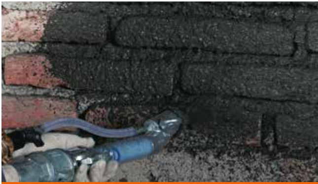
Forbehandling af underlaget ved udkast/påsprøjtning med PCI Saniment® HA for udjævning af ujævnheder
