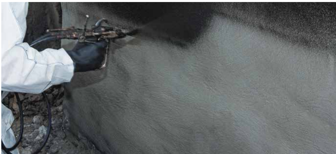
Grunding af kældervæg med PCI Pecimor® F inden påføring af bitumen tyklagsbelægningen
