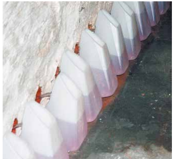
Udførelse af en horisontal spærre med tryklos injektion med PCI Borehuls spærre
