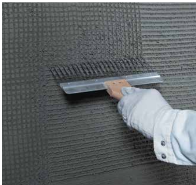
Rugøring af tætningspudsen PCI Saniment® DP med en stålkam inden påføring af saneringspudsen
