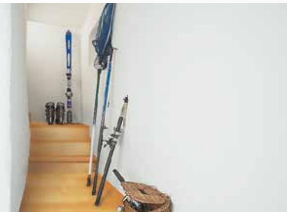
Kælderrum efter sanering
