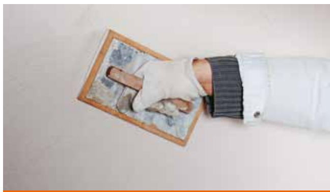
Efterbehandling af vægoverfladen med finpuds PCI Saniment® FP
