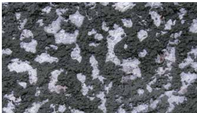
Forbehandling af pudsunderlag ved sprøjtegrundning med PCI Saniment® HA
