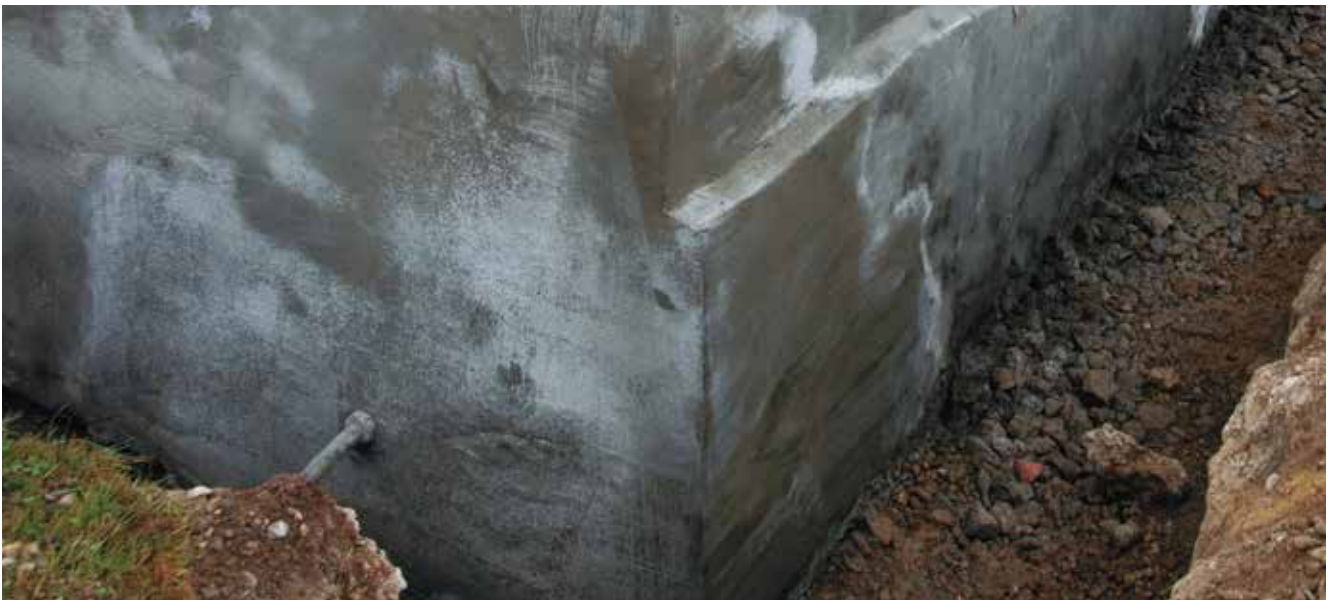
Frilægning og opretning af kældervæg inden påføring af fugtisolering
