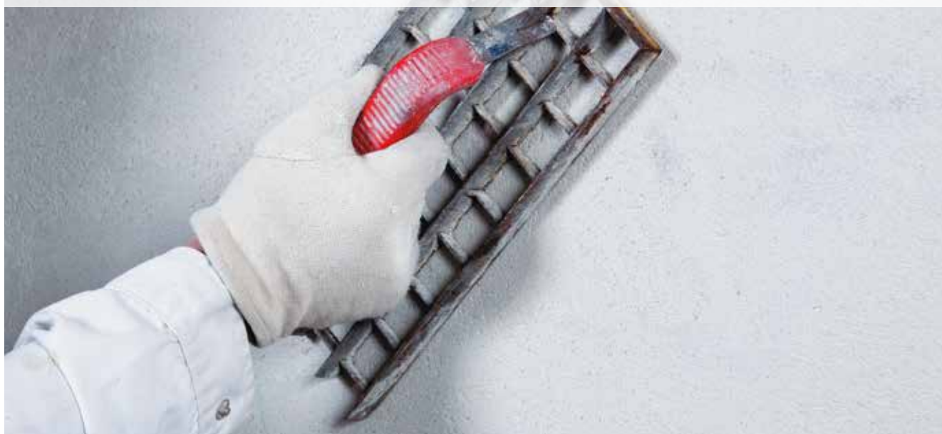
Afretniing af saneringspudsoverfladen på PCI Saniment® Super med Gitterpudsebrættet inden påføring af finpudsen PCI Saniment® FP
