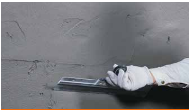
Udjævning af ujævnheder med tætningspuds PCI Saniment® DP
