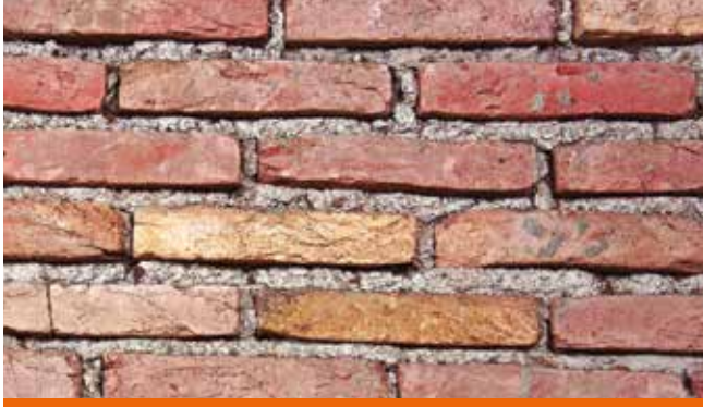
Ujævnt, rengjort murværk
