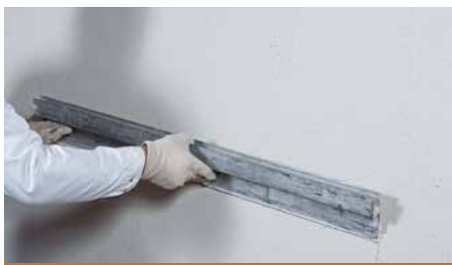
Forarbejdning med et lag af den sulfatbestandige saneringspuds PCI Saniment® Super
