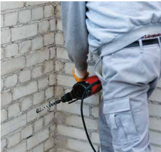
Forberedelse af borehuller inden udførelse af horisontal spærrek
