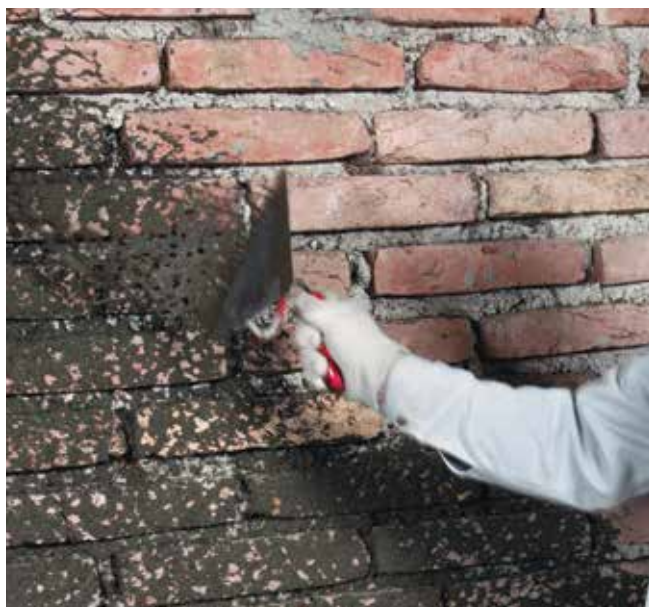
Netformet udkast af mørtlen PCI Saniment® HA med ske
