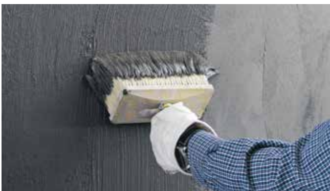
Tætning mod indtrængende fugt med tætningspumme PCI Saniment® DS
